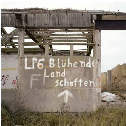
Fabrikrüne im Kreis Demmin 2011
